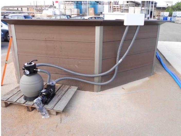
10. Puesta en marcha: Se coloca la válvula en posición de filtración, se abre la tapa del prefiltro y se llena de agua. Se cierra la tapa y se conecta la bomba. En unos minutos la bomba se habrá cebado y el agua estará circulando por el filtro.
