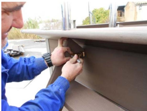
2º Colocamos con los tirafondos los cierres en la posición marcada.
