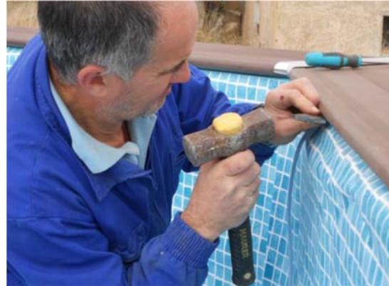
Si se ayuda de un objeto para introducir el Hung, tenga la precaución de que sea de madera, plástico y romo de modo que no pueda dañar el liner.
