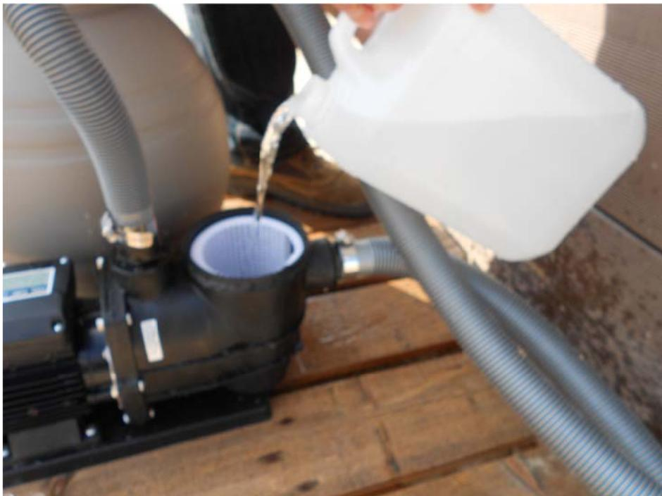
Productos QP advierte que para el cumplimiento de la ITC BT 31 del Reglamento Electrotécnico de Baja Tensión R.D. 842/2002 la bomba debe situarse a una distancia en horizontal del borde de la piscina no inferior a 3.5 m.
