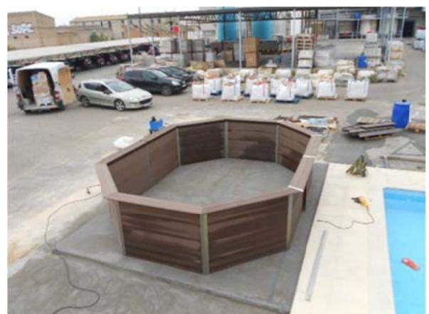
Finalmente montamos las piezas de remate superior sobre el canto del panel, encajadas con la "U" hacia abajo. Observar que hay de 4 tipos según la figura del bisel.
