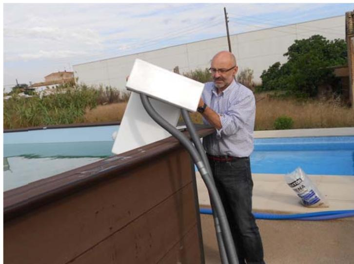
Tomamos el saco con el resto de arenas sobrantes , procuramos cerrarlo bien. Abrimos la cubierta de la mochila skimmer y colocamos el saco para que haga de contrapeso dentro de la parte que apoya en el remate de coronación. Comprobar que la piscina está suficientemente llena como para que el agua alcance sobradamente la puerta del skimmer.
