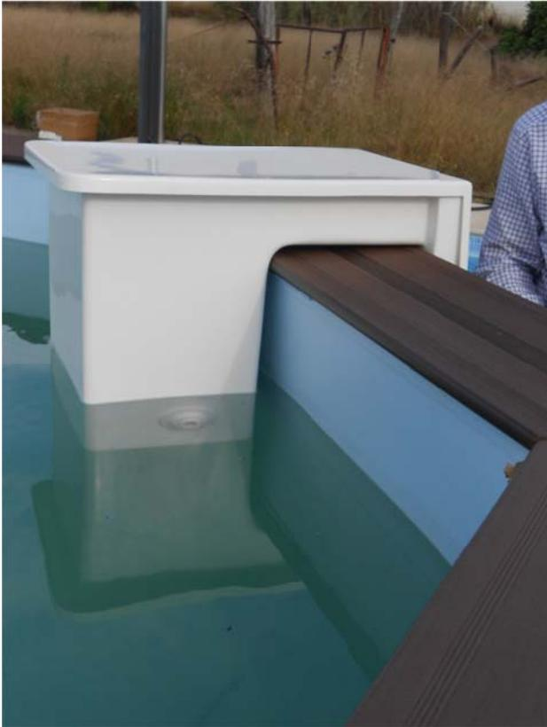
De la mochila skimmer salen dos mangueras: Una está conectada al fondo del skimmer y deberá ser conectada a la entrada horizontal de la bomba. La otra está conectada a la boquilla de impulsión y deberá ser conectada a la salida a piscina de la válvula de 4 vías.
