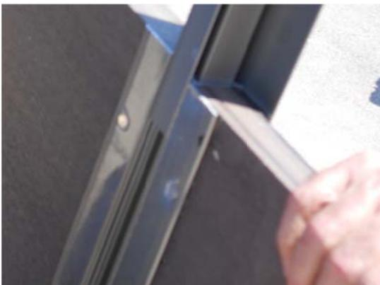
Siempre que una dos paneles ha de hacerlo de modo que las caras interiores queden sobre el polígono de replanteo previamente marcado y el interior del perfil de aluminio sobre su vértice correspondiente. En el caso de las uniones rectas, el centro
